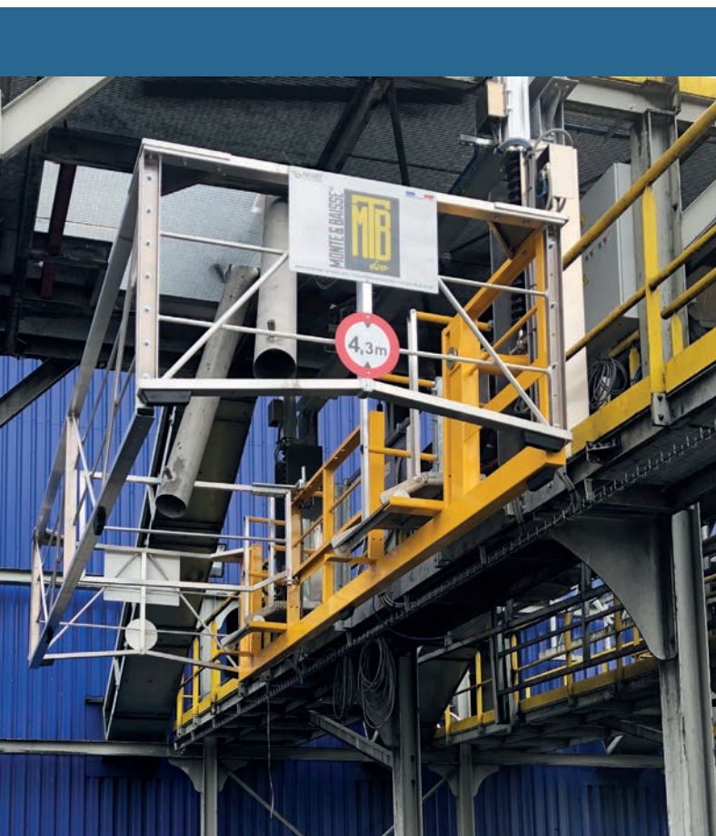
Montage sur site (piste 1).
