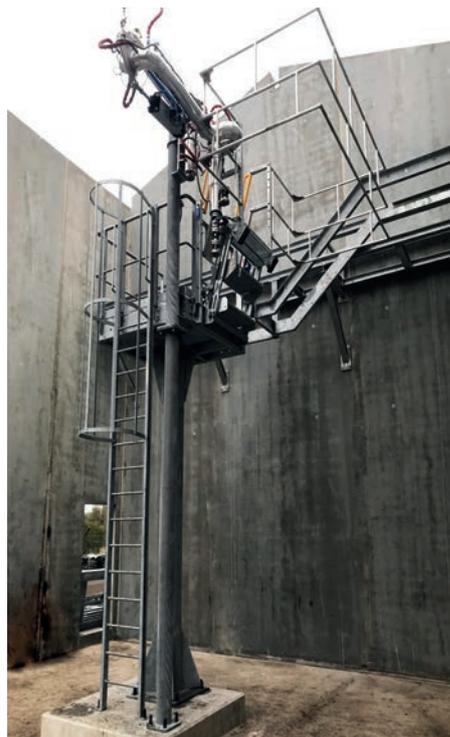
L'ensemble bras de chargement et passerelle à abattant installé sur site.
