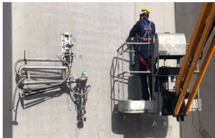
Le bras de chargement en cours d'installation sur site.
